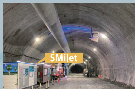
トンネル坑内(2025.5~) (中国地整)俵山・豊田道路第2トンネル(仮称)
